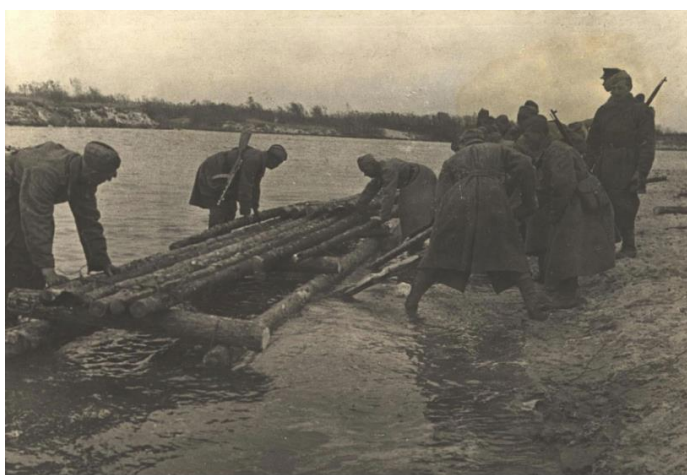
Бойцы сооружают мост через реку Сож.
